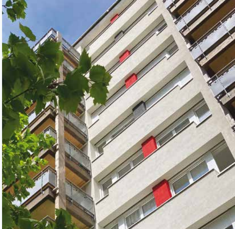
Résidence à Cluses, travaux et création de balcons en 2022, Unanime Architectes Alpes.
