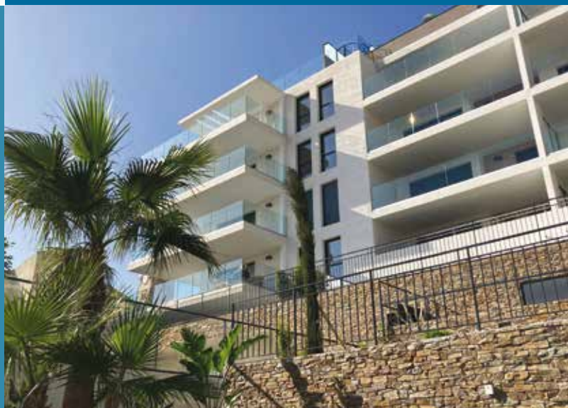
Résidence à Nice, VEFA en 2022, DP Architecture.
